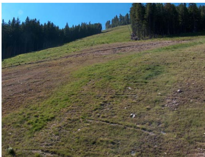
Сн.3: Ски писта „Томба” – изпълнени валове-канавки (сн. инж. И. Петров, юли 2014г.)
