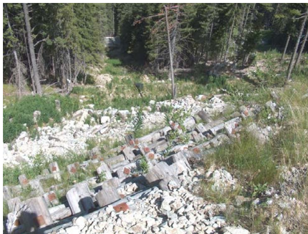
Сн.8: Подпорна стена под ски писта „Томба“ (сн. инж. И. Петров, юли 2014г.)
