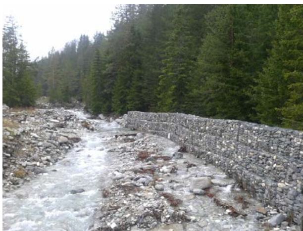
сн. 9: Едностранна корекция на р. Бъндерица преди моста (сн. инж. И. Петров, юли 2014г.)
