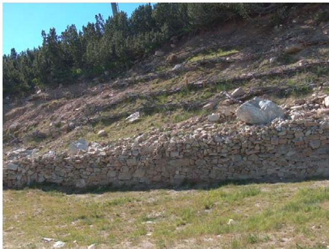
Сн.6: Суха каменна зидария при междинна станция на лифт „Бъндеришка поляна-Междинна станция“ (сн. инж. И. Петров, юли 2014г.)
