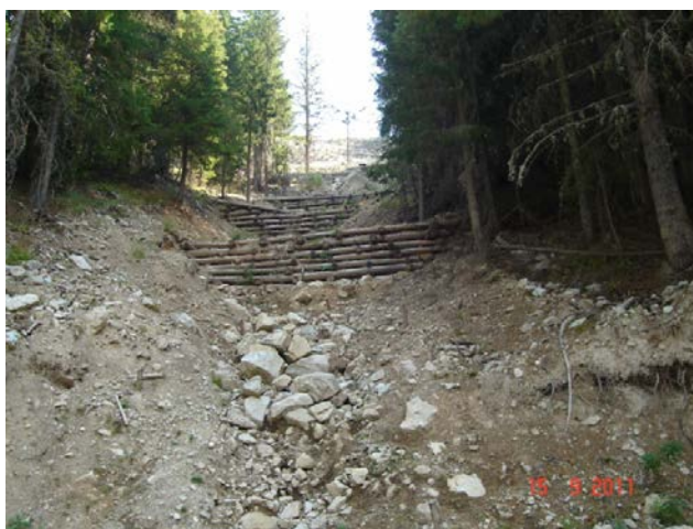
Сн.7: Двустенен дървен бараж – равнината под ски писта „Томба“ (сн. инж. И. Хаджиев, юни 2011г.)
