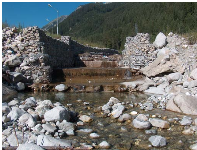
Сн. 10: Продълбаване на дъното на р. Бъндерица (сн. инж. И. Петров, юли 2014г.)
