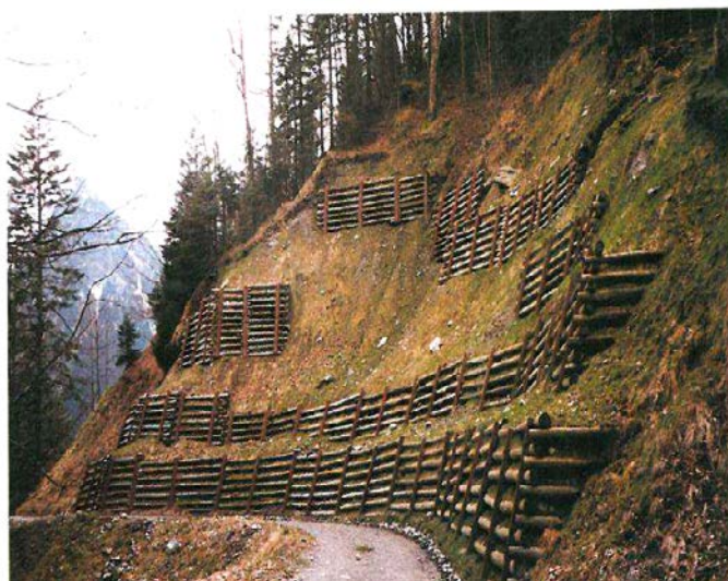
Анкерирани дървени подпорни стени и геомрежи за укрепване на ски-път 1– участък 3
